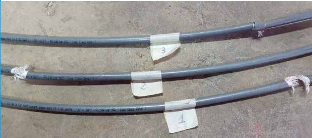
Dettaglio rotture Detail breaks
