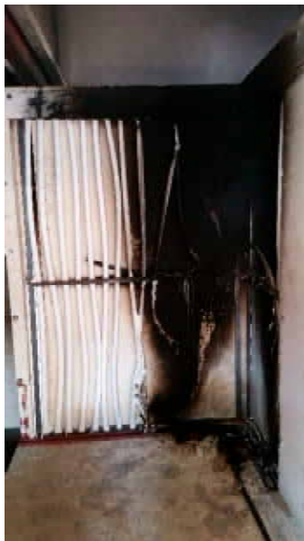
Vista lato maggiore dopo test Side view larger after the test
