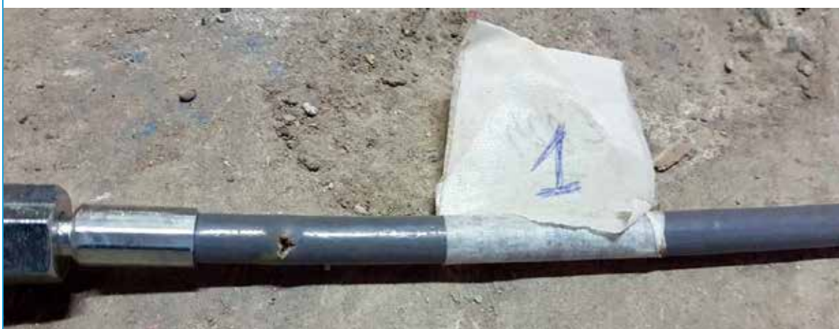
Dettaglio rotture Detail breaks
